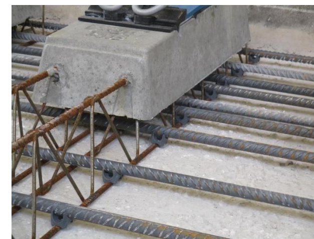
Figura 5. Ejemplo de distribución de clips aislantes para la separación de refuerzos metálicos
